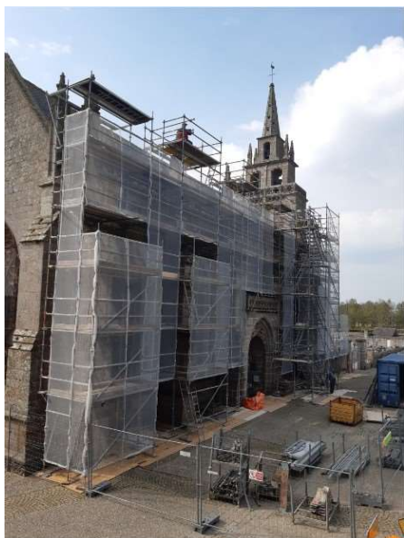
Mise en place des échafaudages
