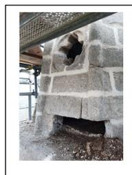
Nettoyage de l'intérieur de la flèche. Nouveaux joints à la chaux
