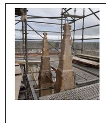
Clochetons sculptés à l'identique, repositionnés à la chaux et goujonnés
