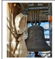
Support moteur cloche 2 à remplacer
